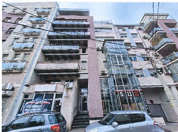
stambena zgrada – ulični izgled
